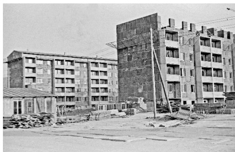
Foto: J. Spiegel 1968 - Rohbau ASS 10-18 von West (B 96, heute Netto -Markt).
